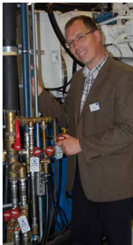
Mats Svensson förklarar hur injusteringsventilerna på formsprutmaskinens kylvattenretur fungerar.
